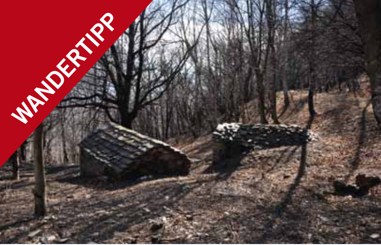
Abb. 1: In den Hang gebaute Quellfassungen als Kühlräume kurz vor Luera
